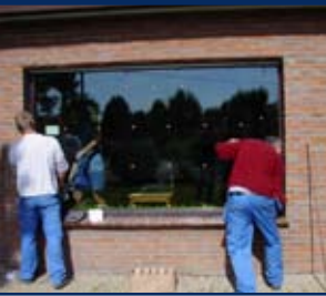
Vervanging van enkel glas door hoogrendementsglas.
